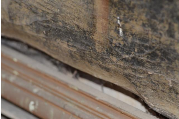
Perte de maintien en partie basse et déformations
